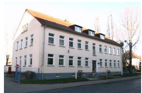
Das Gebäude in der Beseritzer Straße 11 ist gleichzeitig Sitz des Landesrechnungshofes Mecklenburg-Vorpommern.
